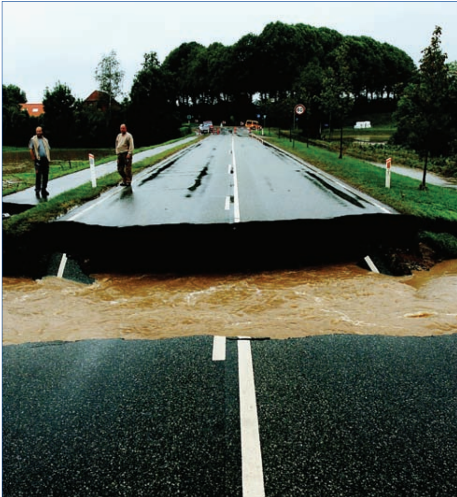
Med stigende risiko for skybrud i fremtiden vil kloakker og veje blive sat under større pres. Nye vejregler vil være med til at sikre mere funktionsdygtige afløbssystemer. Foto: Jesper Balleby/Jyske Vestkysten.
